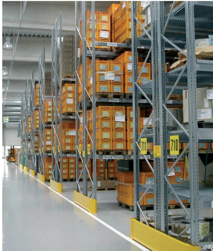
Das P90 Breitgang-Palettenregal bietet uneingeschränkten Zugriff auf alle Paletten. Breite und Tiefe richten sich nach den verwendeten Palettenformaten. Es kann in Einzel- und Doppelzeilen montiert werden.
