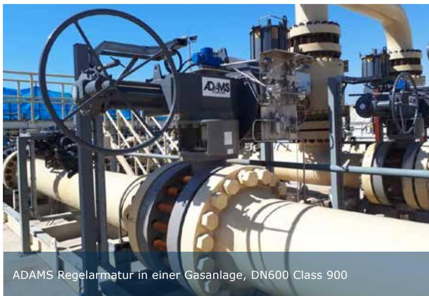
ADAMS Regelarmatur in einer Gasanlage, DN600 Class 900
