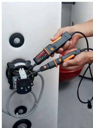
Spannungsmessung an einem Heizlastspeicher.
