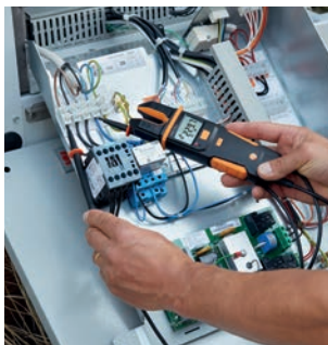
Spannungsmessung an einem Verdichter.
