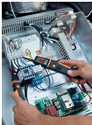
Spannungsmessung an einem Verdichter.
