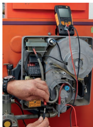
Aufbau der Ionisationsstrom-messung.
