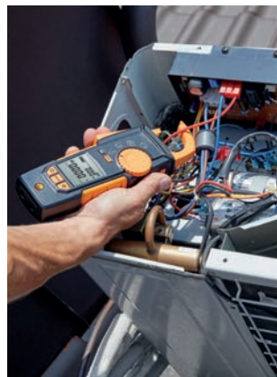
Einfädeln der Stromzange an einer Kälte-Ausseneinheit.
