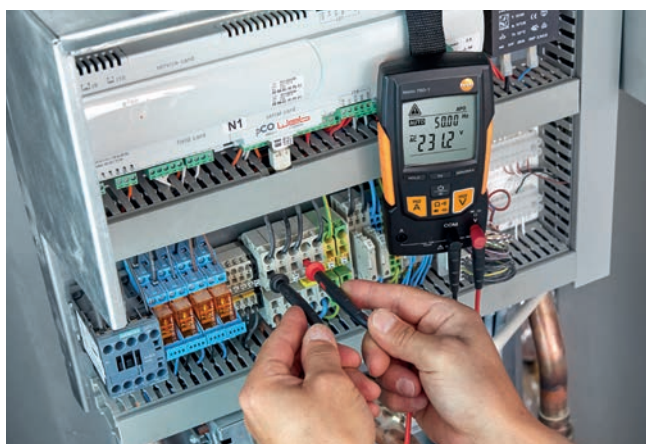
Spannungsprüfung am Schaltfeld einer Wärmepumpe.
