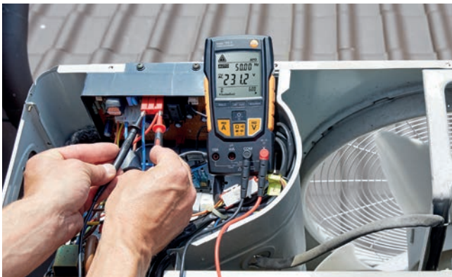
Spannungsmessung an einer Kälte-Ausseneinheit mit testo 760 .
