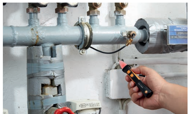
Spannungsüberprüfung an einer Verteilerdose mit testo 745 .
