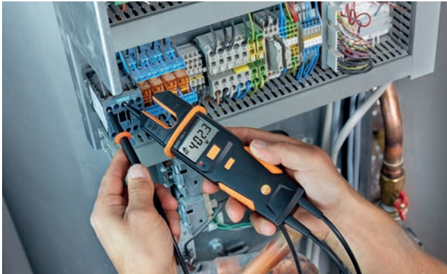
Spannungsprüfung an einer Wärmepumpe mit testo 755 .
