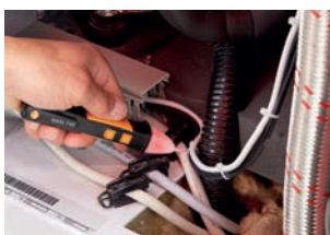
Erstprüfung der Spannungsversorgung an einem Verdichter.
