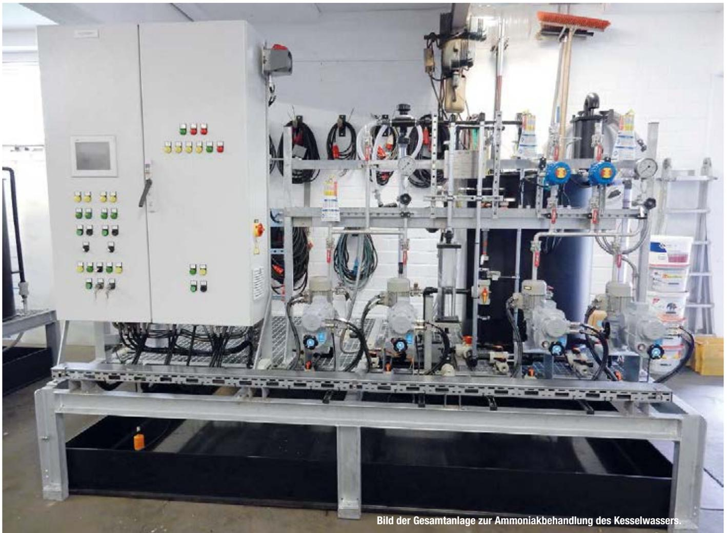
Bild der Gesamtanlage zur Ammoniakbehandlung des Kesselwassers.
