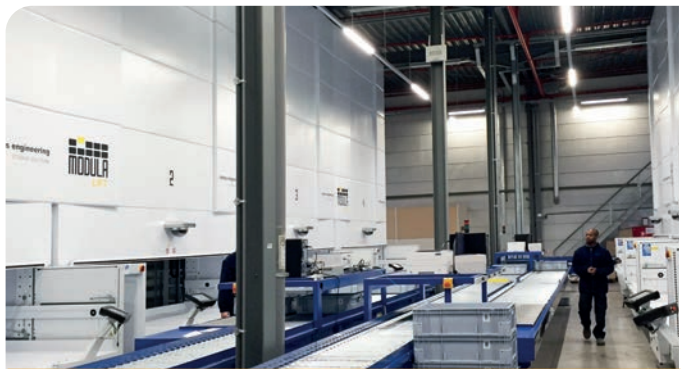
Kombination mit Förderbändern und Rollenförderern
