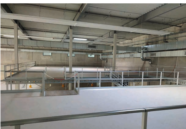
Lagerbühne mit Palettenaufgabe und Sicherungskette
