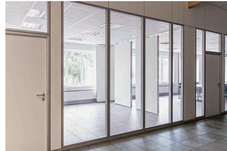
Mobilwand mit Ein-Punkt-Aufhängung an Systemtrennwand
