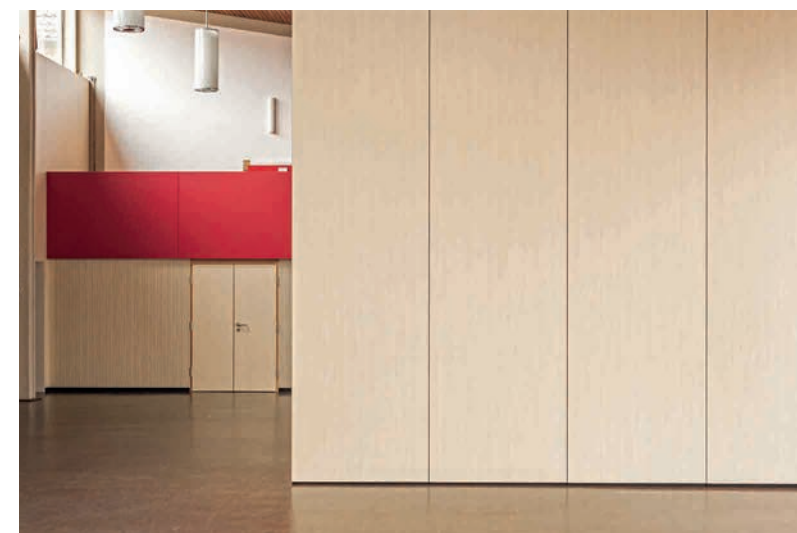
Keine Bodenführung, frei hängende Elemente, einzeln verfahrbar über Deckenlaufschiene aus Aluminium
