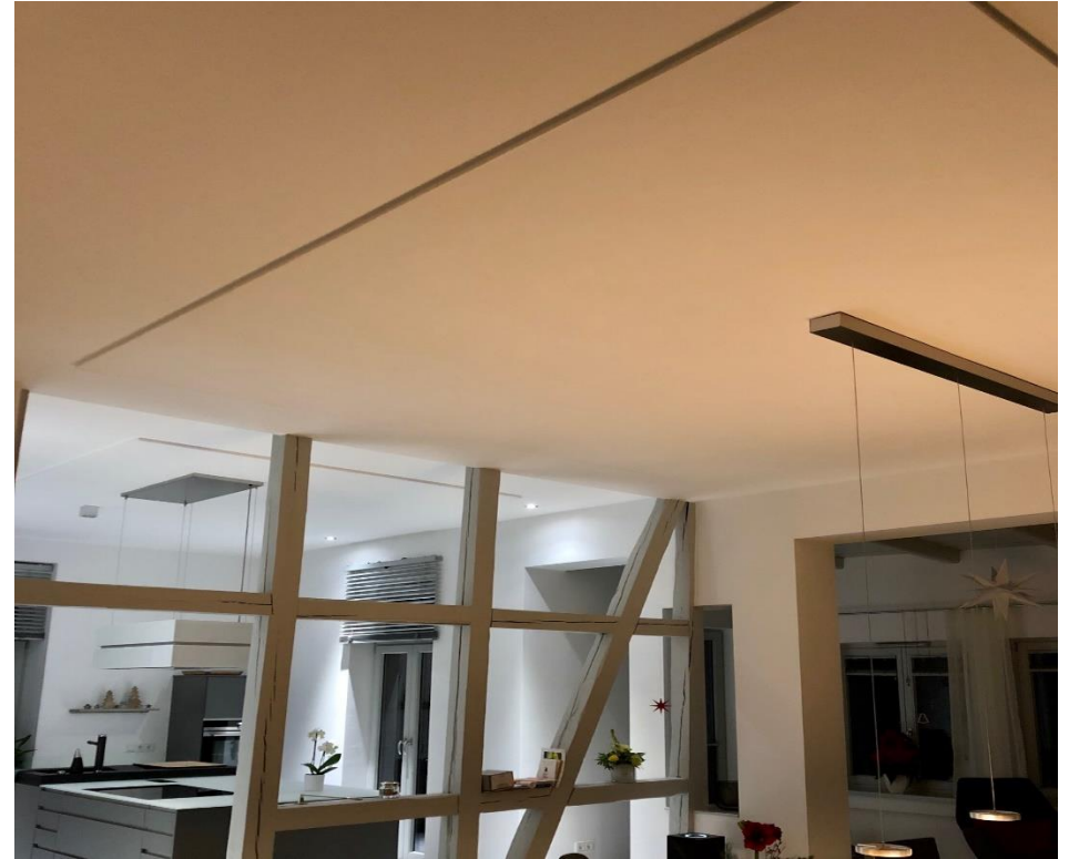
Deckensegel, wassergeführt von oben angebunden.
