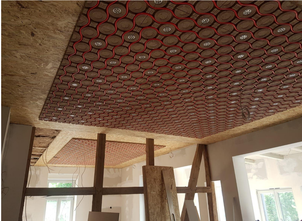
Deckensegel, wassergeführt von oben angebunden.
