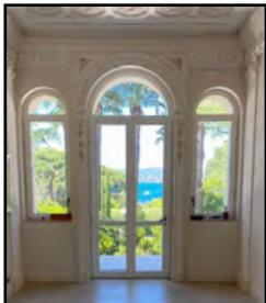
Solutions environnementales: châssis en bois pour respecter les matériaux d'antan et utiliser des matériaux biosourcés. Facilité de maintenance des châssis avec un grand ensoleillement.
