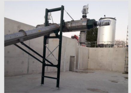
Schrägförderschnecke mit Stopfschnecke
