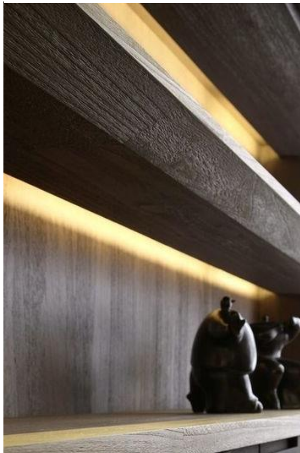
Planken op afstand geplaatst met indirect LED
