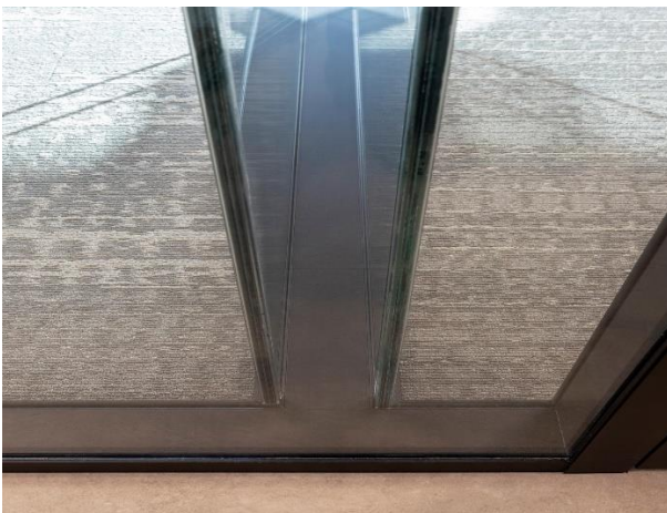
(detail T-aansluiting met joints)
