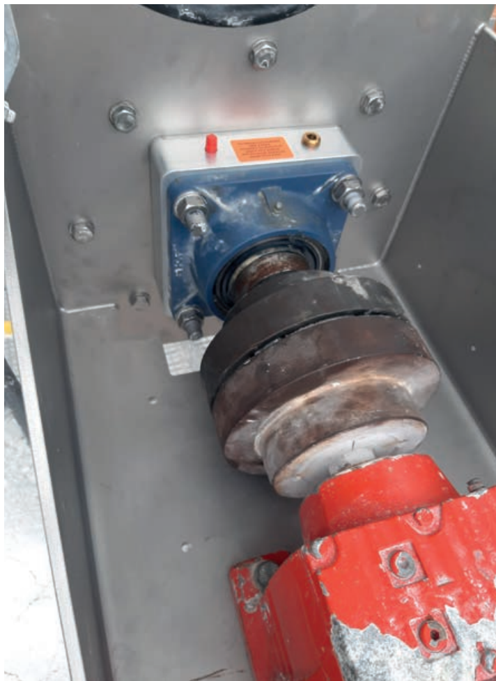
Afb. 3 De motor (onder) drijft via de koppeling en het (blauwe) lager de transportschroef aan. Het lager is gemonteerd op de CinchSeal asafdichting.
