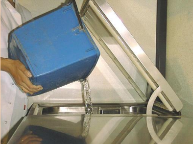
Vidoir traditionnel - chasse d'eau à déclenchement sans contact
