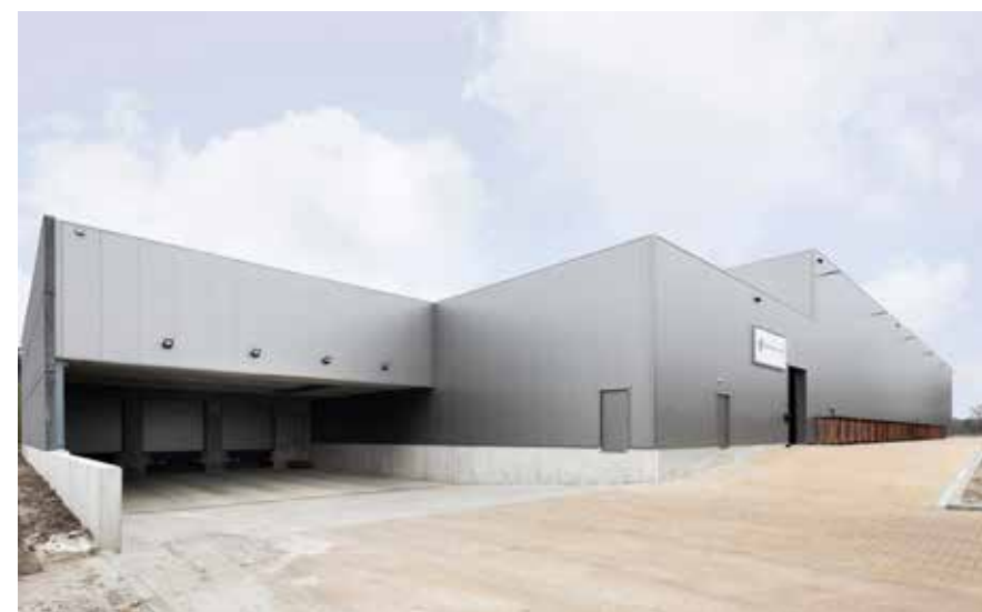
De opslaghal bestaat uit een staalstructuur die omgeven is door een betonplint en sandwichpanelen. De gevels van het aanpalende kantoorgedeelte zijn bekleed met silexbetonpanelen.
