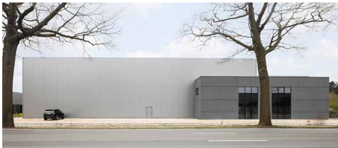
De nieuwe opslaghal van Belgium Warehousing & Logistics is circa 100 meter breed, 50 meter lang en 11 meter hoog.
