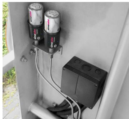
In una segheria i cuscinetti di un trasportatore a catena si trovano ad altezze irraggiungibili. Il collegamento Bluetooth® a simalube IMPULSE connect consente di monitorarli in tutta praticità.
