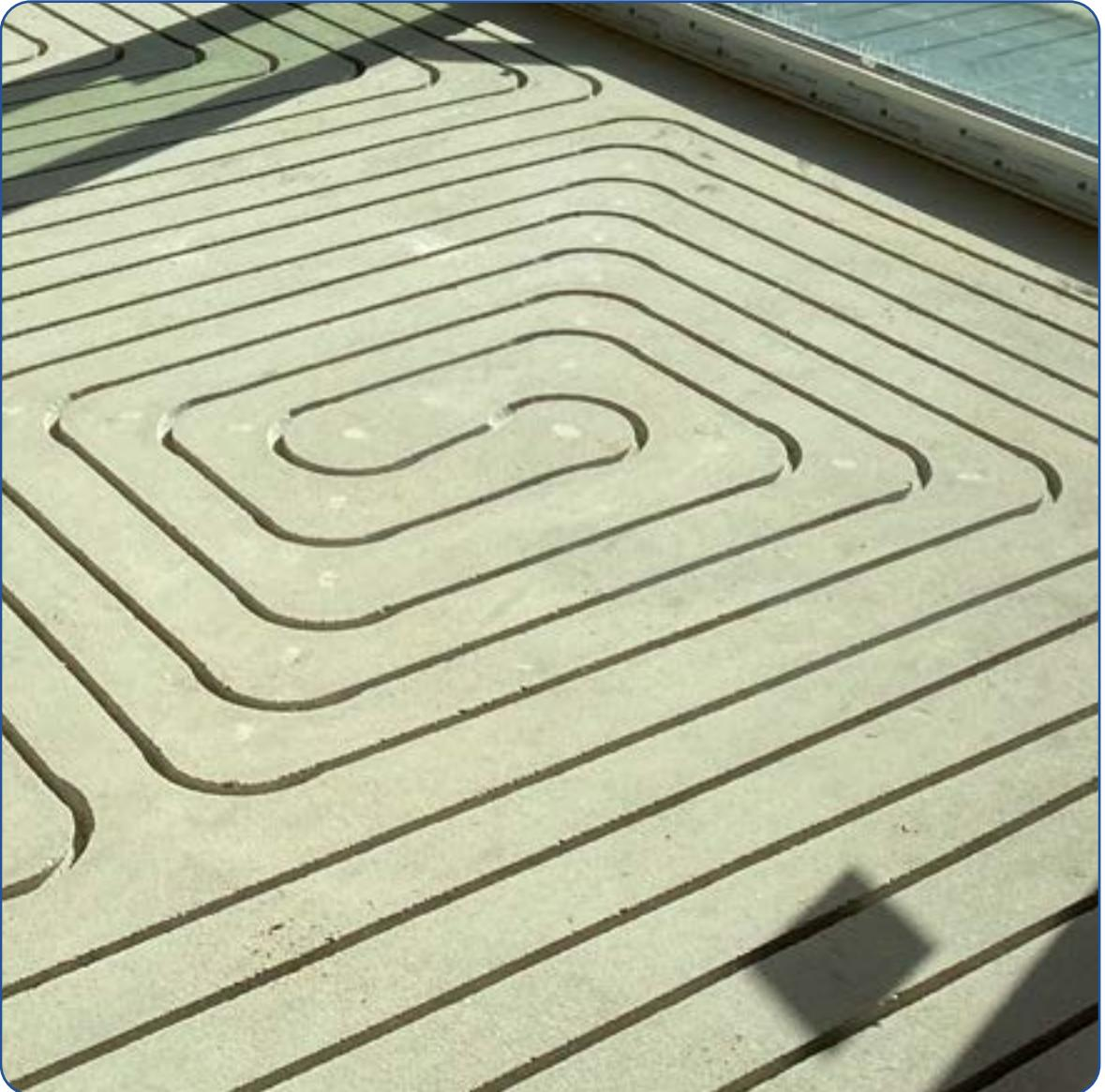
Chauffage sol dynamique, à faible inertie
