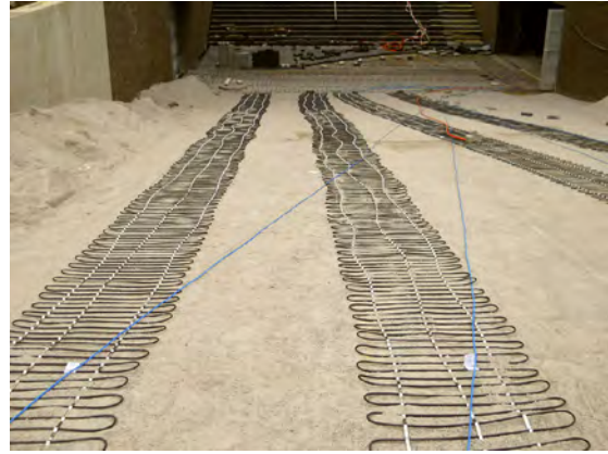
Uitvoering met matten onder klinkers
