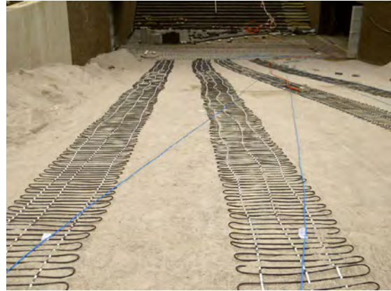
Uitvoering met matten onder klinkers
