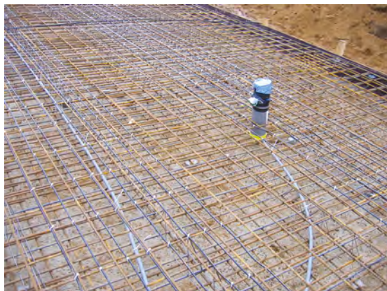
Plaatsen van de sensoren
