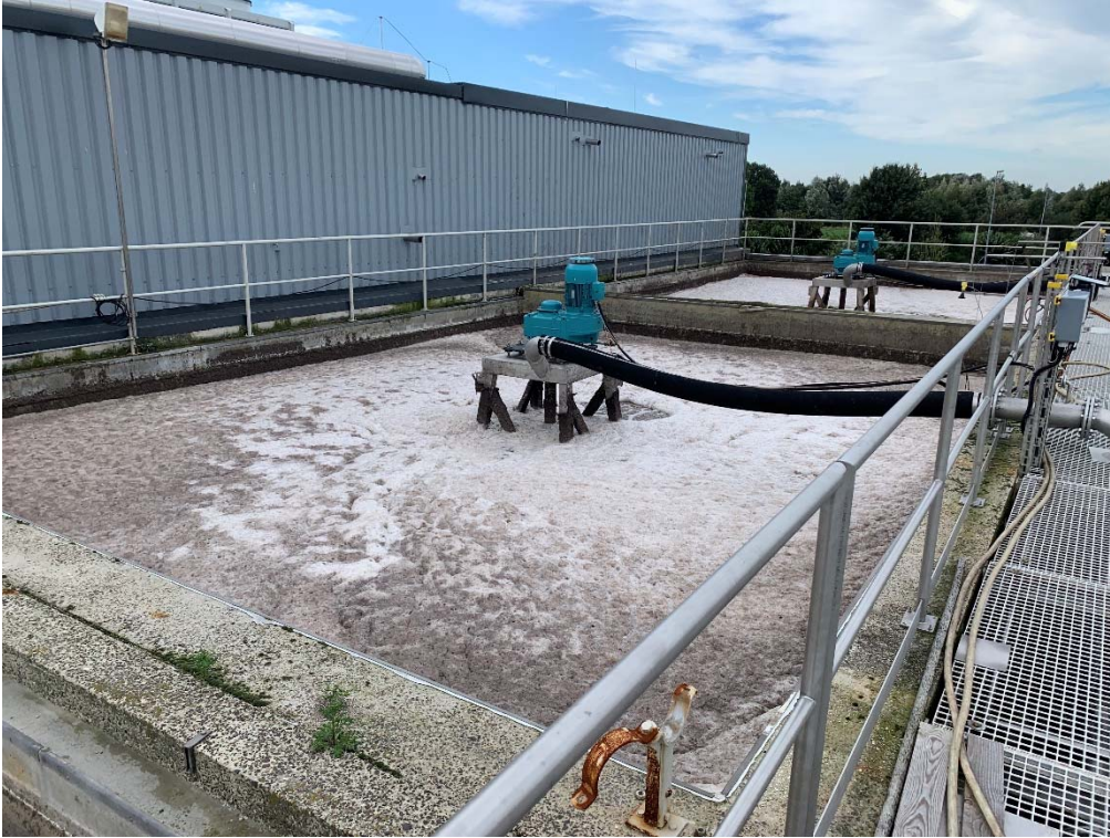
Foto 5: Twee van de HYPERCLASSIC ® menger- en beluchtingssystemen in een kooi bij de papier- en kartonfabriek Varel
