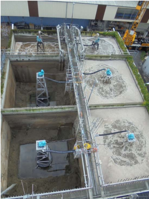
Foto 1: HYPERCLASSIC ® menger- en beluchtingssystemen worden compleet met kooi in het bassin neergelaten
