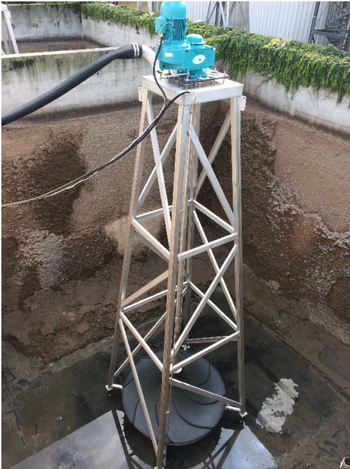
Foto 3: HYPERCLASSIC ® menger- en beluchtingssystemen in een kooi – er wordt vlak op bodem geroerd en belucht
