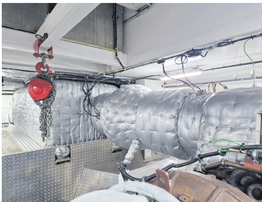
▲ De nabehandelingsinstallatie paste gemakkelijk in de machinekamer. (foto Mourik EGP)
