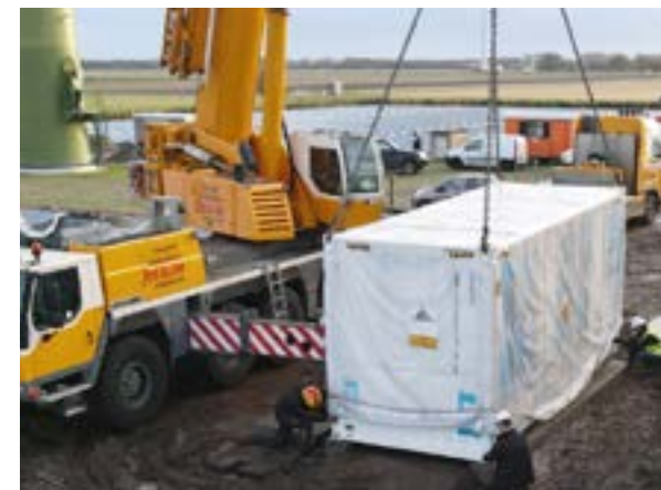
Batterijcontainer wordt op de plaats gehesen.
