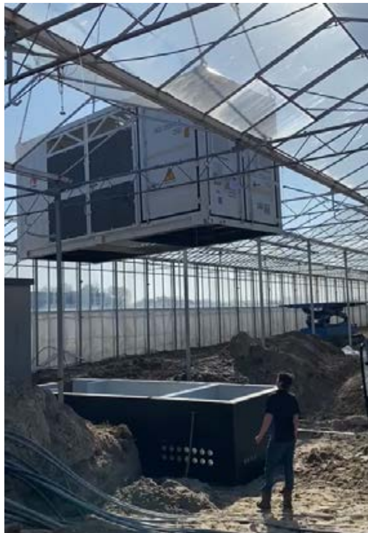
Plaatsen van een transformator
