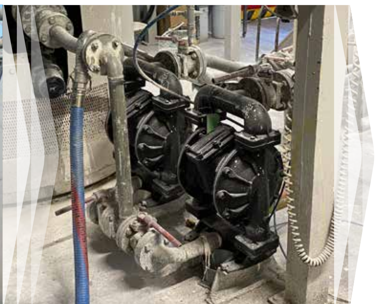
Eine hohe Viskosität der Flüssigkeit verringert die Förderleistung der Pumpe.
