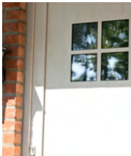
1 Kader 2 Vleugel 3 Vulling (paneel of glas)
