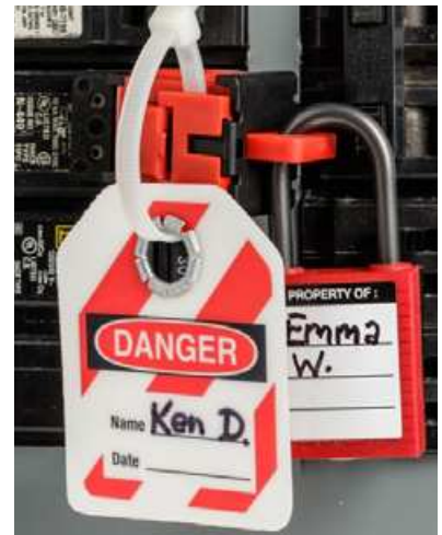
Kann mit Kabelbindern und/oder einem Sicherheitsschloss gesichert werden
