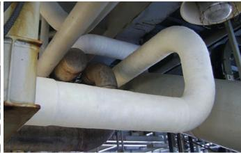
Reparatur bei Korrosion unter Isolierung (CUI)
