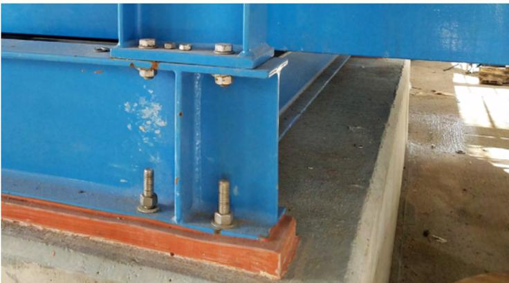
Sicherung und Unterfütterung von Maschinenfundamenten und -sockeln, um Vibrationen und Erschütterungen standzuhalten, sowie 100% Form- und Kraftabschluss
