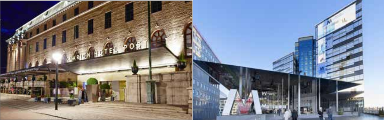
Två av våra referensanläggningar som har installerat Hiss-UPS, Post Hotel Göteborg och Mall Of Scandinavia, Stockholm.
